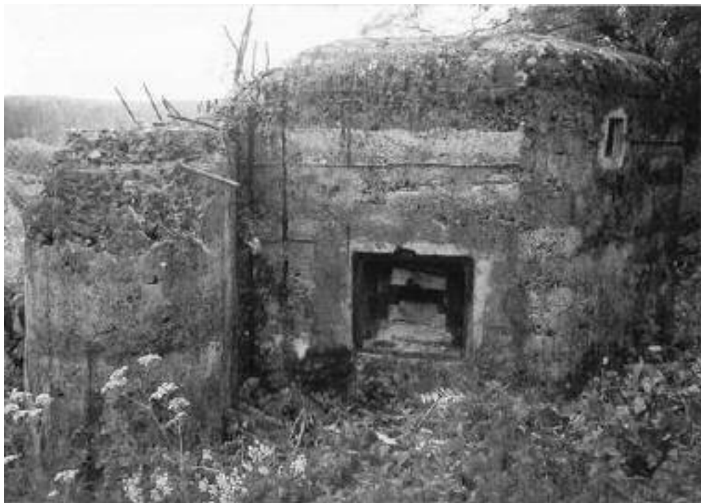
Betonerődítmény maradványa a Tornalja melletti Beretkénél
